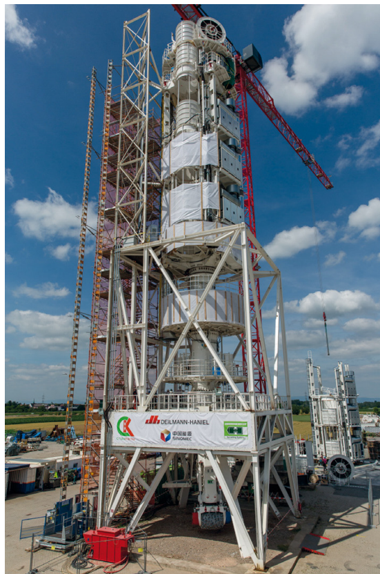
Bild 2: Shaft Boring Roadheader (SBR) der Herrenknecht AG
