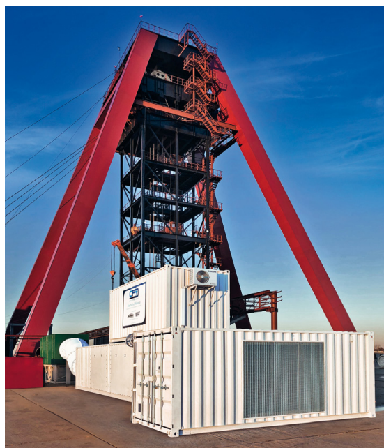
Bild 7: Inbetriebnahme der Schachtbewerterungsanlage für Schacht 2 auf dem Bergwerk in Weißrussland
