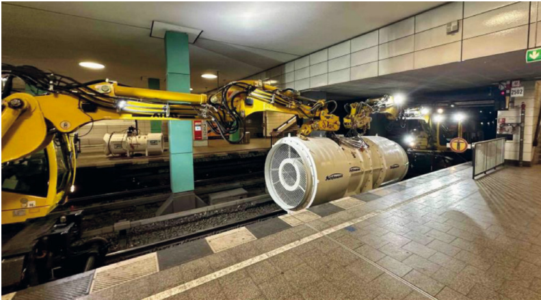
Bild 2: Lüfterpositionierung mit Zweibegebagger beim Aufbau
