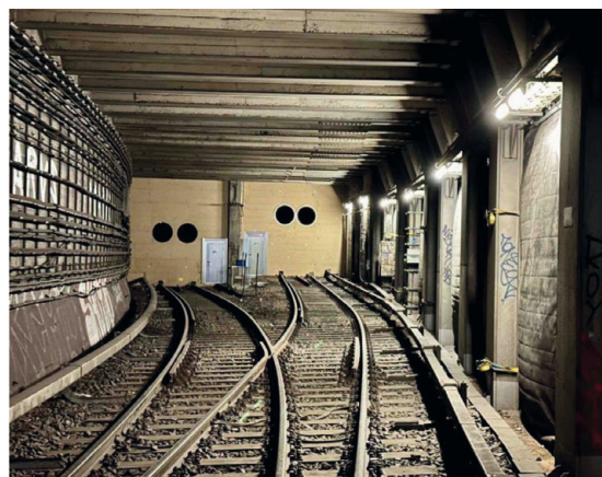
Bild 5: Wetterwände zur Abschottung staubhaltiger Arbeitsbereiche vom restlichen Tunnel
