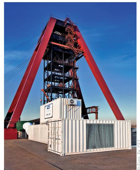
Inbetriebnahme der Schachtbewetterungsanlage für Schacht 2 auf dem Bergwerk in Weißrussland
