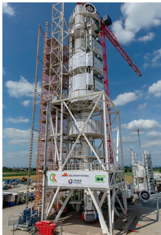
Рис. 2: Стволопроходческий комплекс (SBR) фирмы Herrenknecht AG. Источник: Herrenknecht AG
