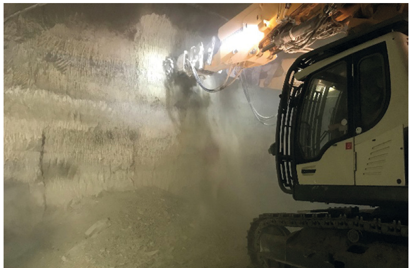
Bild 1: Vortrieb mit Baggerfräskopf
