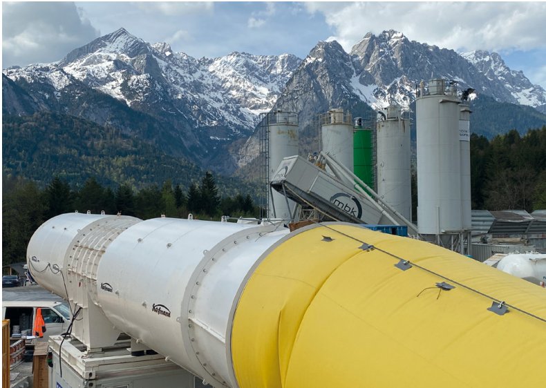
Bild 2: Blick auf die Baustelle des Kramertunnels mit Ventilations-einrichtungen der CFH Gruppe
