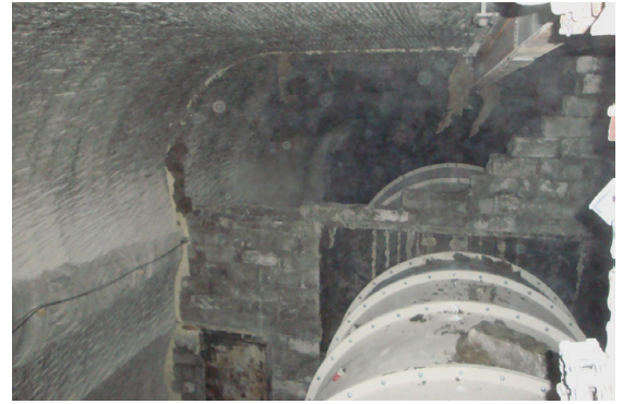
Bild 4: Eingestürzte Wetterwand
