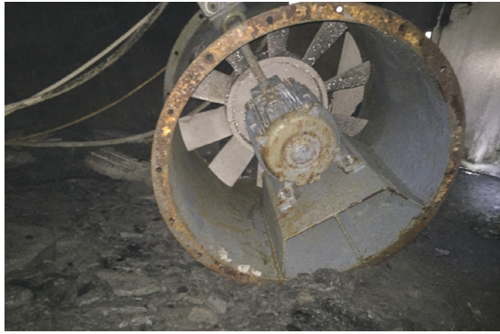
Bild 3: Handling unter Tage
