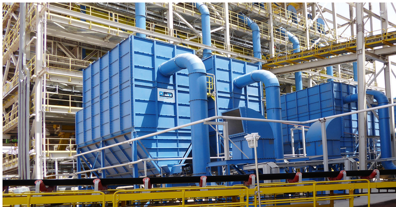
在毛里塔尼亚的铁矿石分离中应用的 Deichmann 袋式除尘器
