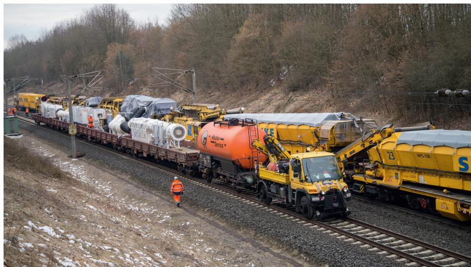
**Abb. 1:** Während des Pilotversuchs im Kalbachtunnel wurde die Entstaubungsanlage auf dem zweiten Gleis neben der Bettungsreinigungsmaschine RM 900 S entlanggeführt. *Quelle: CFT GmbH*
