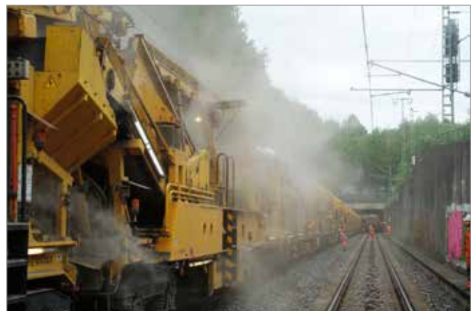
Bild 2 Staubentwicklung im Betrieb der Bettungsreinigungsmaschine Development of dust during operation of the ballast cleaning machine
